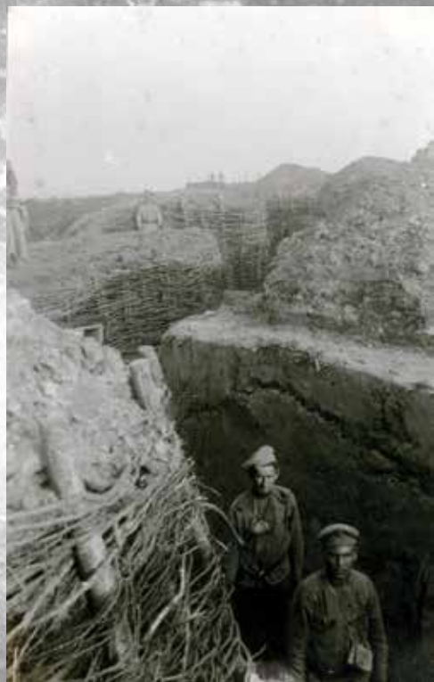
Druhá linie rakousko-uherských zákopů na opevněné výšíně Mogila
