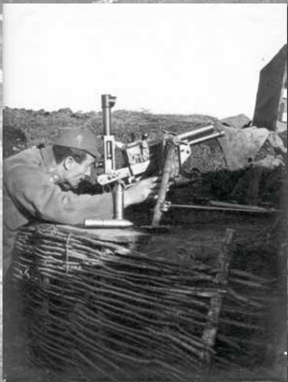
Rakousko-uherský zákopový kanón vzor 15 soustavy Škoda s periskopickým zaměřovačem
