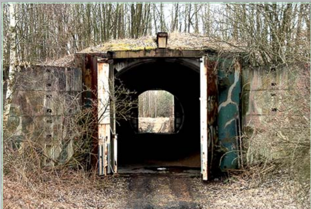
Úkryty mobilních odpalovacích zařízení OTR-22 Temp S dochované ve vojenském prostoru Libavá
