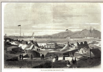
Výstavba rakouského velkého opevněného předmostí u Florisdorfu u Vídně za prusko-rakouské války roku 1866. Během ní podali rakouští ženisté opakovaně vynikající výkony.
