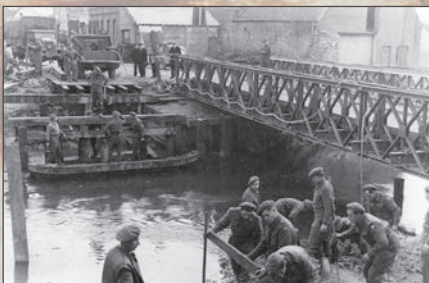
Most Bailey Bridge, vybudovaný u Dunkerque ženisty Československé samostatné obrněné brigády. (zdroj VÚA–VHA)
