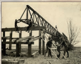
Výstavba železné mostní konstrukce – vrchol umu ženijního vojska
