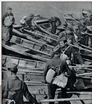
Při stavbě mostního soulodí
