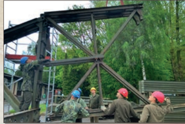
Výstavba mostních provizorií je nedílnou součástí ženijních schopností, které ženisté získávají na kurzech organizovaných Ministerstvem dopravy České republiky zpravidla ve Výcvikovém středisku Ministerstva dopravy v Kojetíně. Mezi nejčastěji využívané patří kurzy na stavbu náhradních mostů ze souprav MS-21 a těžkých mostových souprav TMS. Získané dovednosti byly ženisty nespočetněkrát uplatněny při odstraňování následků povodní na území Česka.
