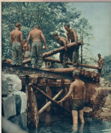
Stavba dřevěného mostu
