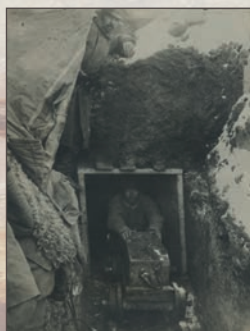
Vyvážení materiálu při hloubení tunelu na italské frontě (zdroj VÚA-VHA)
