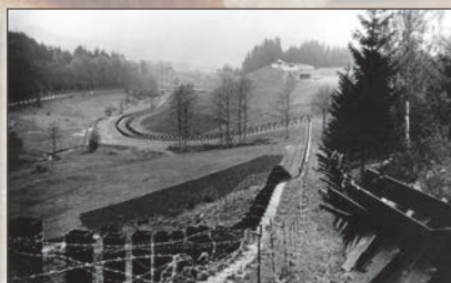
Ženisté československé branné moci se výrazně podíleli na výstavbě stálého opevnění z let 1935–1938.
