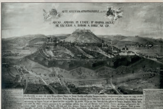
Příprava brněnské pevnosti na obléhání roku 1742 zobrazuje probíhající ženíjní práce: zbourání části předměstí, zesílení stálého opevnění pevnosti prvky polního opevnění a položení linie záseků (pokácené stromy s větvemi proti nepříteli zpomalily postup pěchoty stejně jako pozdější ostnatý drát). (zdroj Wikimedia Commons)
