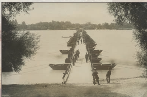
Improvizovaný most, vybudovaný za pomoci soulodí
