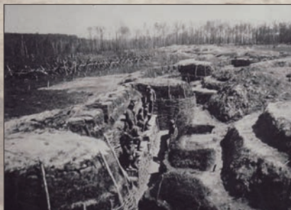
Rakousko-uherské zákopy vyztužené traverzami a doplněné liniemi ostnatého drátu v Halči na východní frontě. Zdi jsou kvůli zpevnění vypleteny proutím. (zdroj VÚA–VHA)
