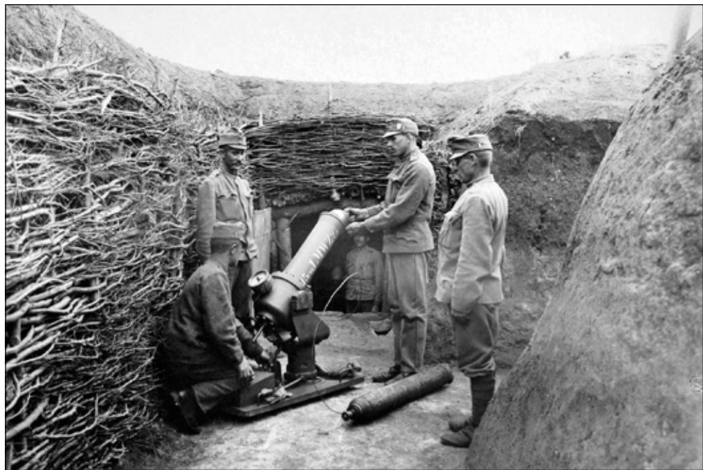
15cm pneumatický zákopový minomet vz. 15 M. E. německé firmy Maschinenfabrik Esslingen byl používán německou i rakousko-uherskou armádou.
