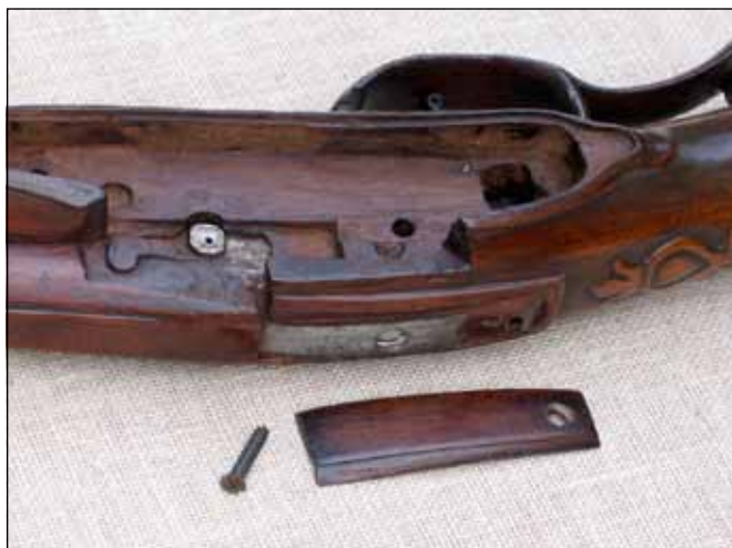
Pod středovou částí pažby je zcela nově vyrobená destička, která překrývá výběžek dnového šroubu.
